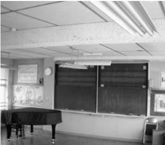
アスベストが問題となっている古月小学校の音楽室
