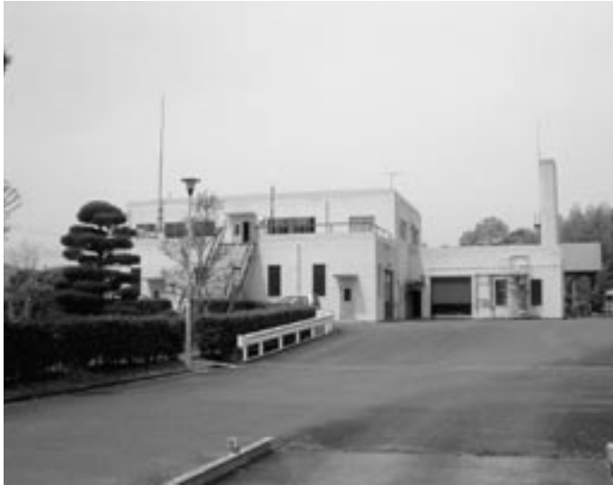
鞍手町衛生センター（し尿処理施設）
