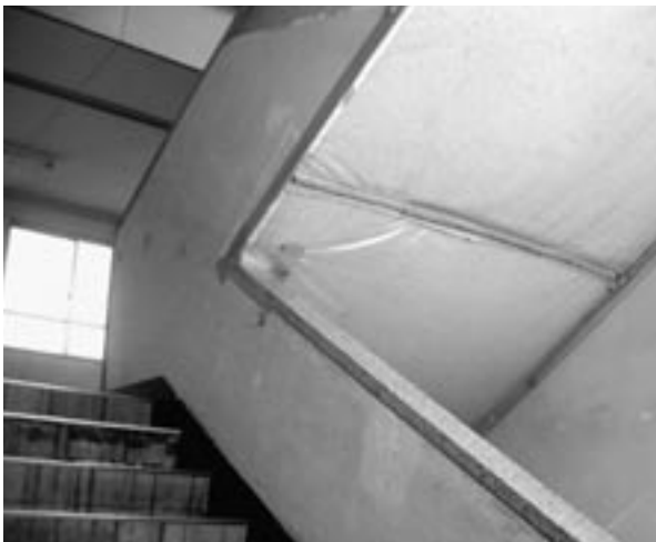
鞍手北中学校の階段
