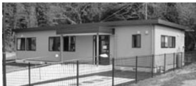
総合福祉センター敷地内の学童保育所
