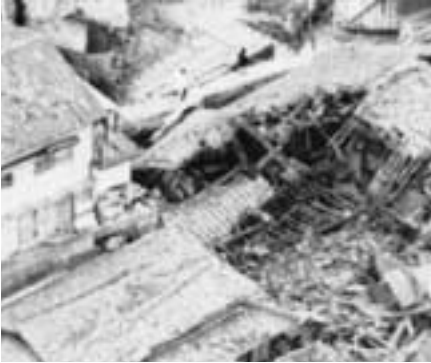
地震で屋根が崩れ落ちた民家
