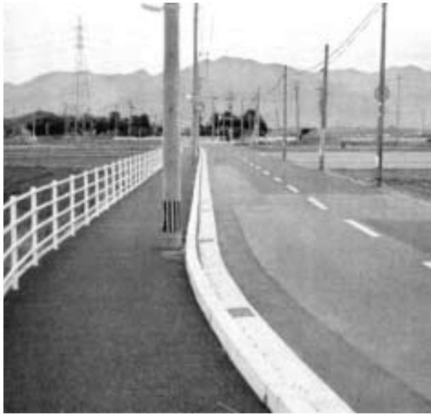
防犯灯が設置された木月・上木月の道路
