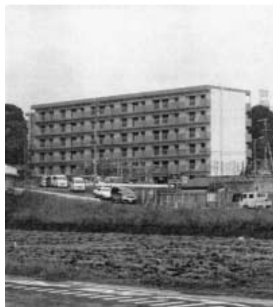
建設中の八尋県営住宅
