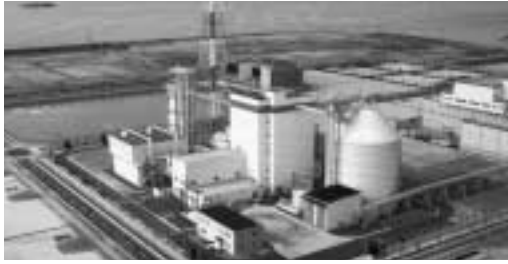
大牟田リサイクル発電所
