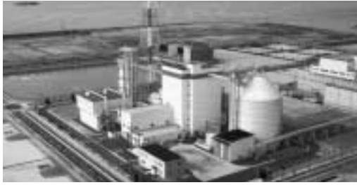
大牟田リサイクル発電所
