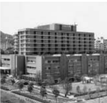
新築移転した九州厚生年金病院
