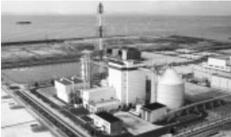
大牟田リサイクル発電所
