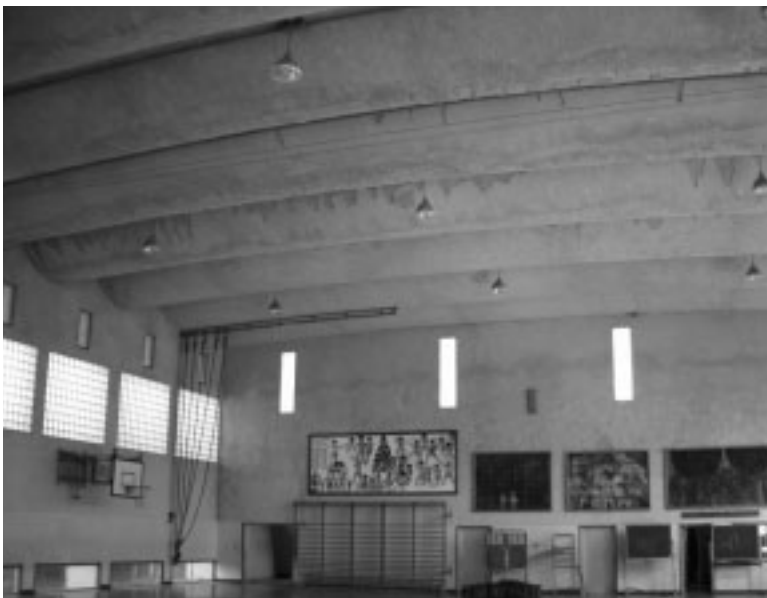
アスベスト調査が行なわれる西川小体育館
