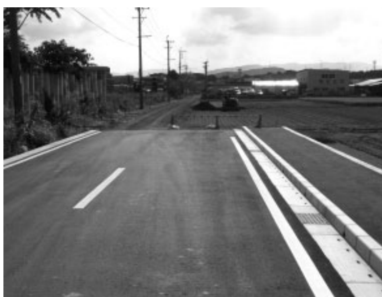
長崎〜藤郷線道路改良工事の現場
