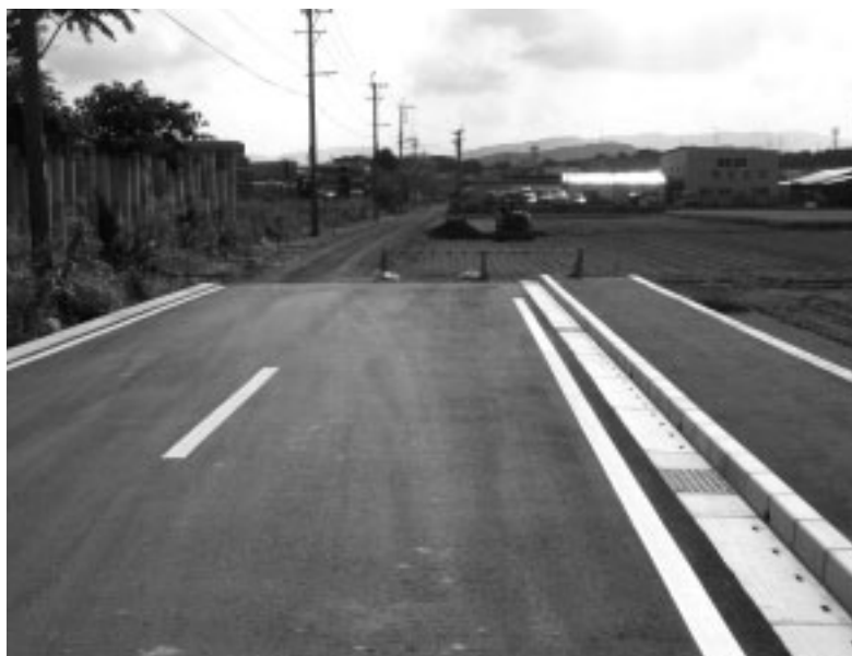
長崎〜藤郷線道路改良工事の現場
