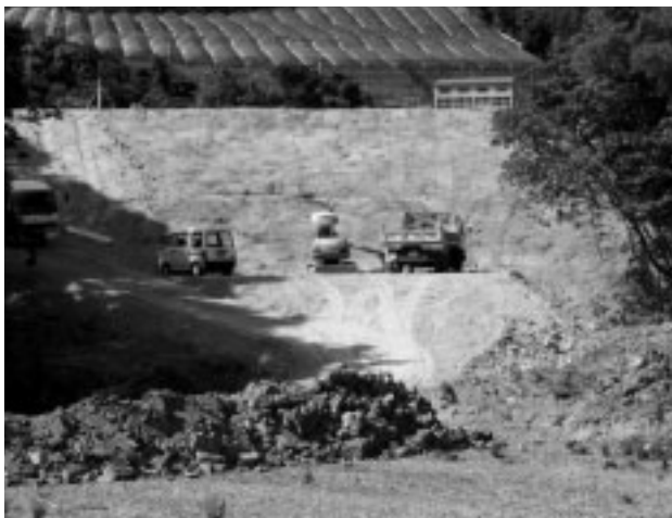
補修工事のはじまった乙ヶ谷ため池
