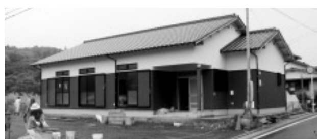
建設中の永谷公民館
