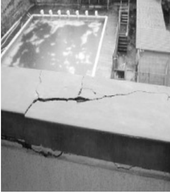
南中学校のベランダのひび割れ
