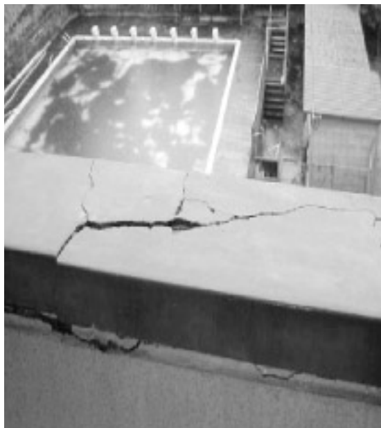
南中学校のベランダのひび割れ
