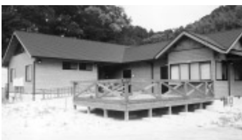
完成した管理棟
