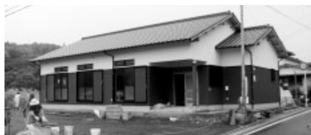
建設中の永谷公民館
