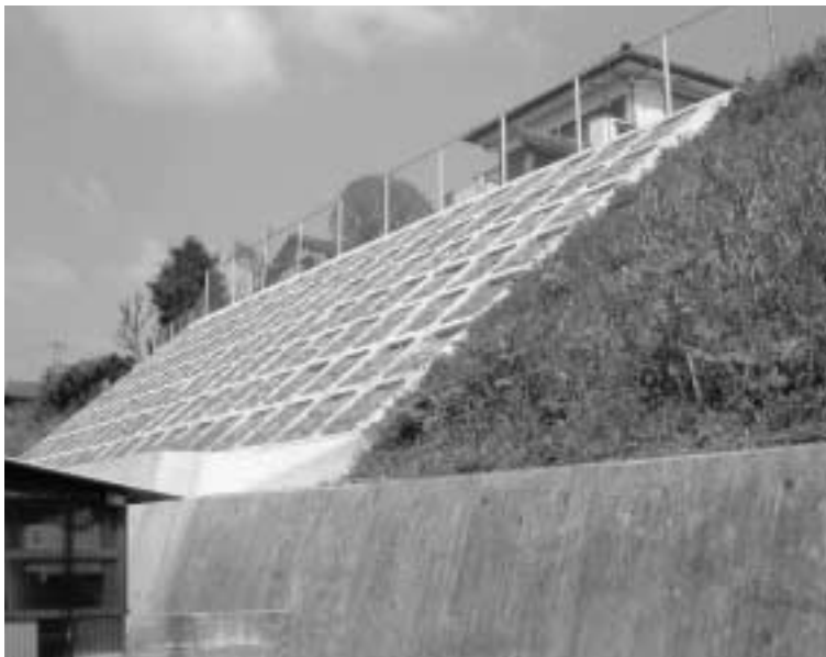
急傾斜地崩壊対策事業(城ヶ崎)
