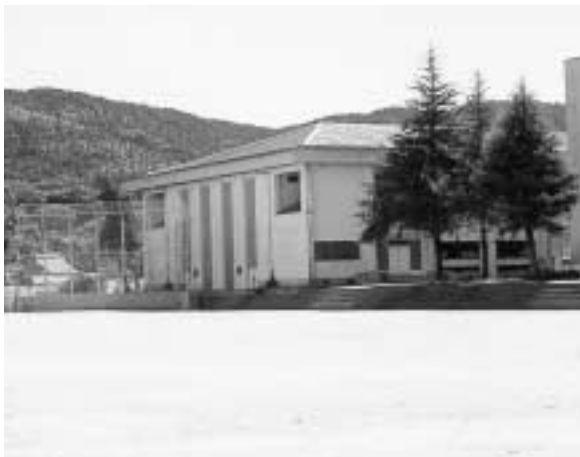
鞍手南中学校体育館
