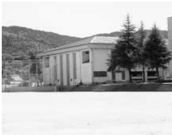
鞍手南中学校体育館
