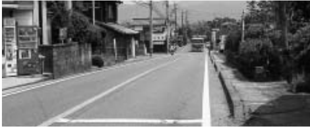
県道直方～宗像線（新延小学校付近）
