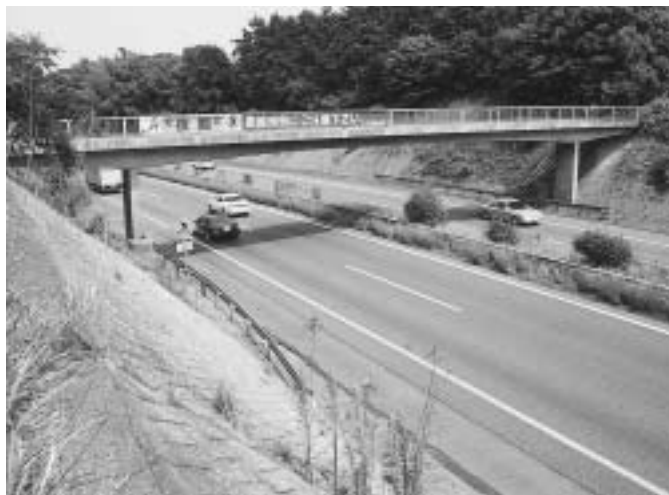
九州縦貫道に架かる下松尾橋
