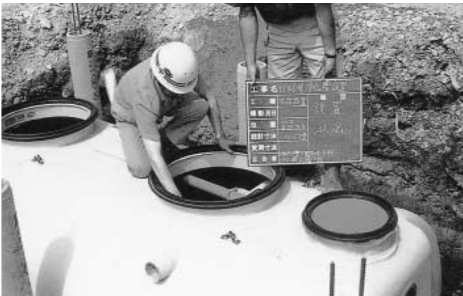
合併浄化槽のタンクのすえつけ
