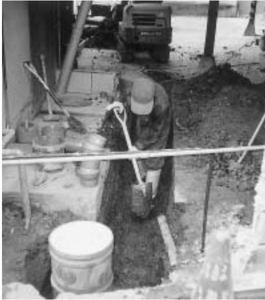
個人住宅の水洗化工事
