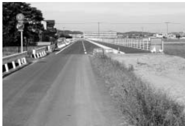
拡幅工事が行なわれている石ヶ崎～く又ギ崎線
