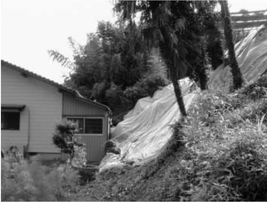
大雨による法面崩壊(立林地区)
