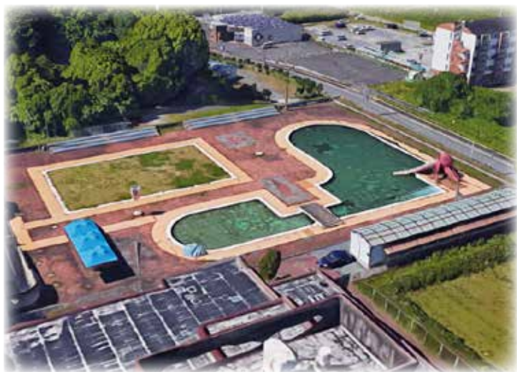
▶ 鞍手総合プール
