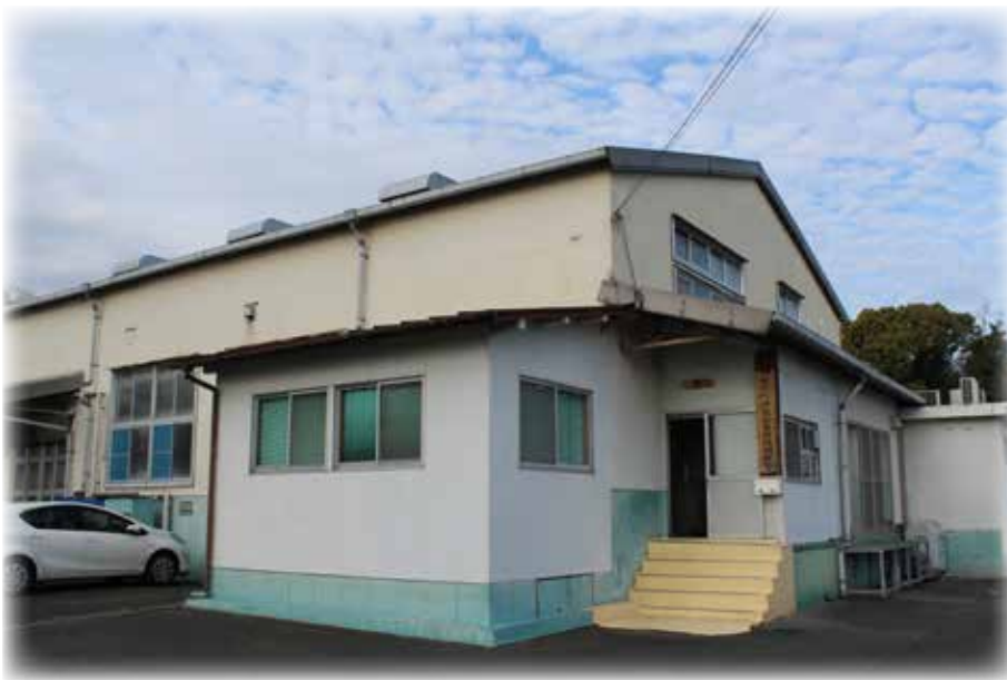
▶老朽化が進む給食センター
