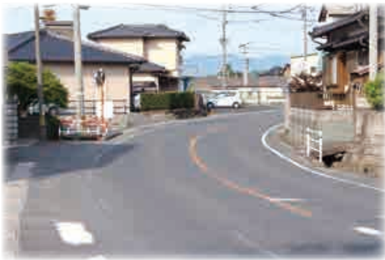
▶ 浸水対策が急がれる町道本町・新延線
