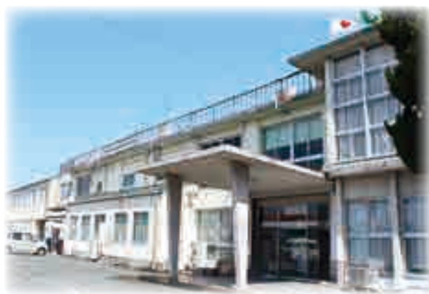
▶耐震診断を行う役場庁舎
