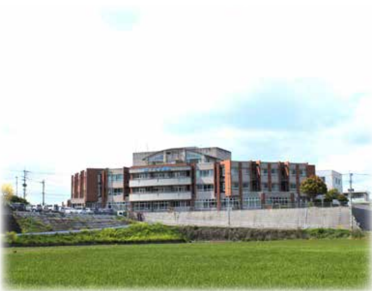
▶運営の正常化が急務となる「くらで病院」
