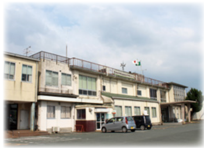
▶地震の際に、倒壊が心配される役場庁舎
