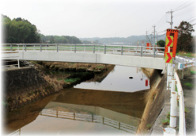
西川に架かる「たぶ木橋」
