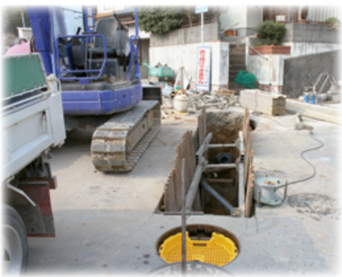
▶整備中の下水道工事
