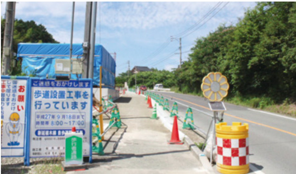
▶歩道整備が進む産業道路（立林付近）
