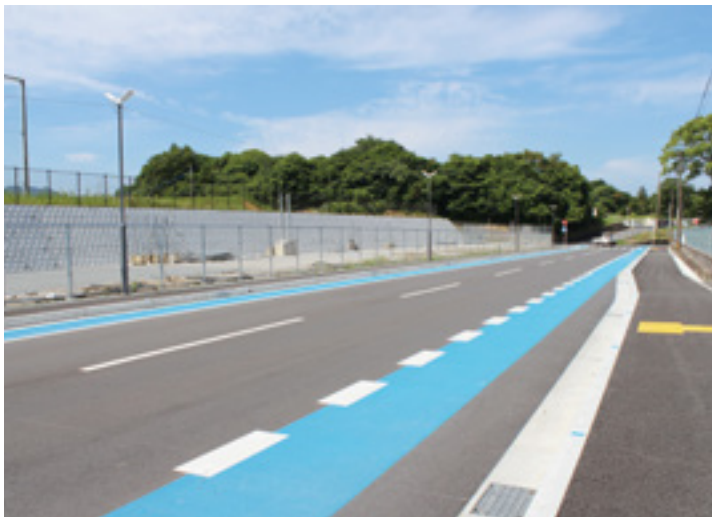
▶ 通学路に舗装された青色自転車レーン
