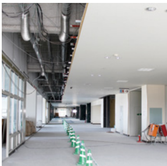
▶改修工事が進む鞍手中学校屋内の状況
