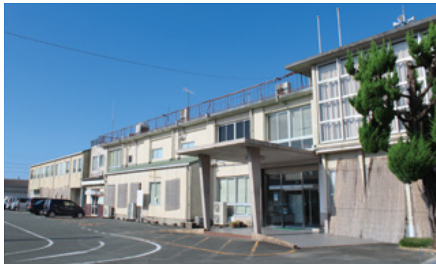
▶老朽化が進む役場庁舎
