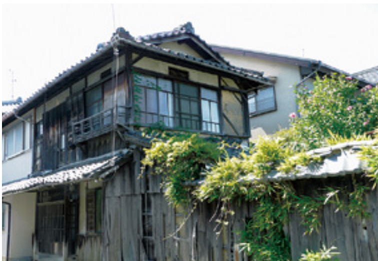
▶老朽化した空き家
