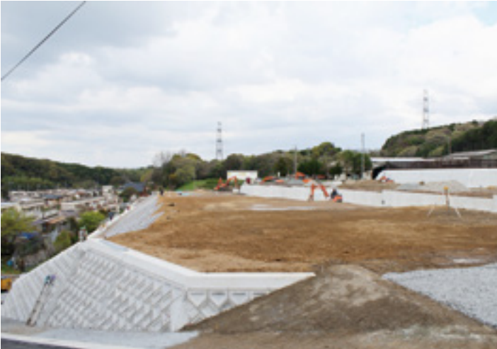
▶造成工事が進む泉水団地改良住宅用地
