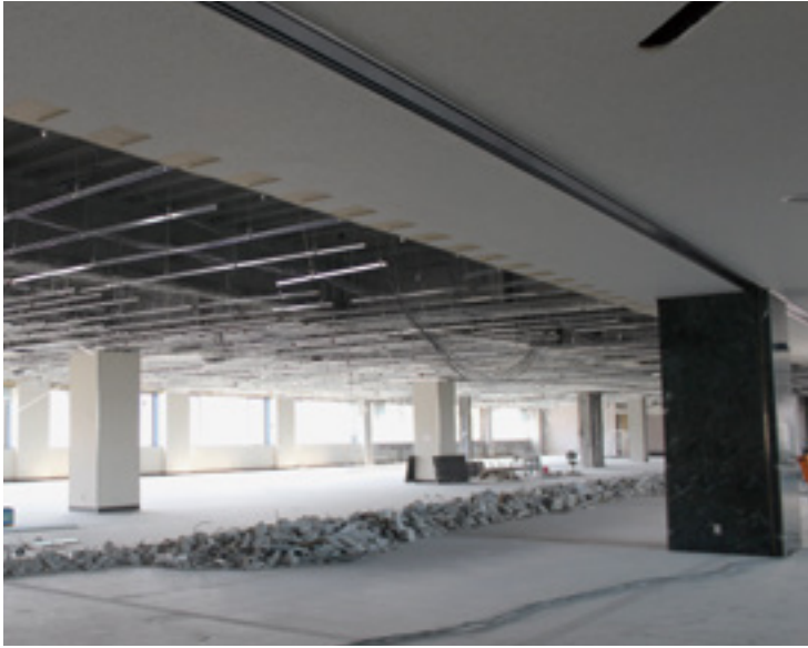
▶改修工事が進む新中学校屋内の状況
