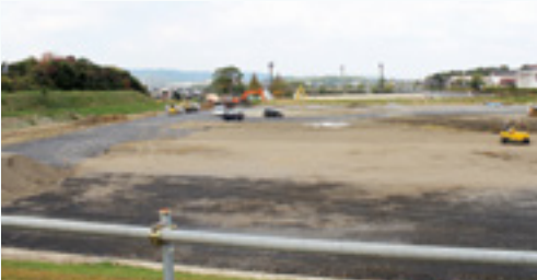
▶整備工事が進む鞍手中学校屋外運動場
