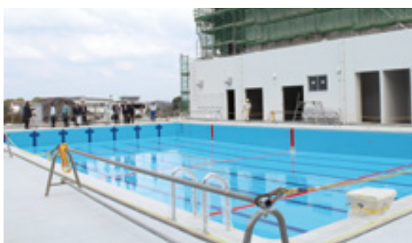
体育館横のプール
