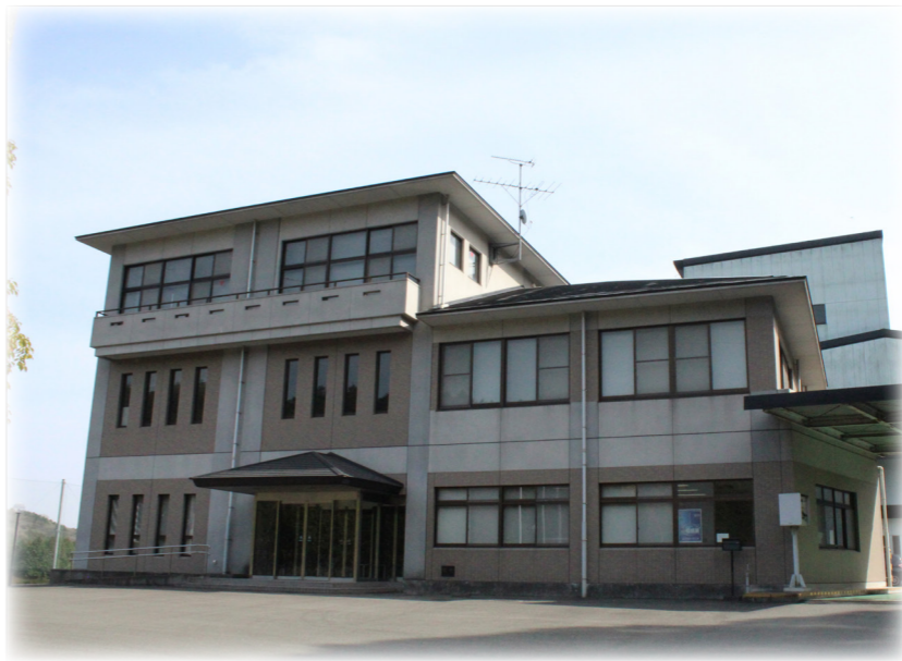
▶宮若市外2町くらじクリーンセンター
