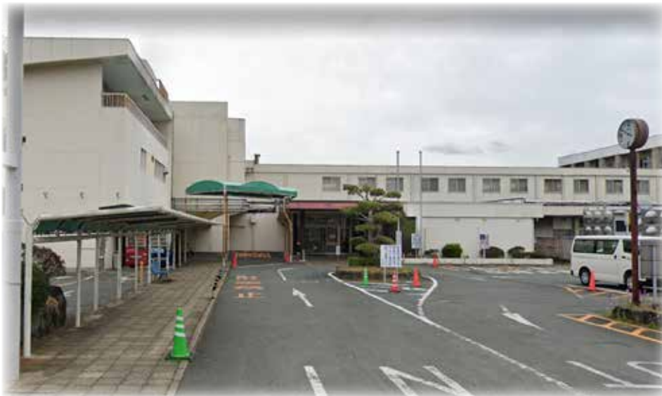
▶発熱外来として屋外コンテナを整備している「くらて病院」
