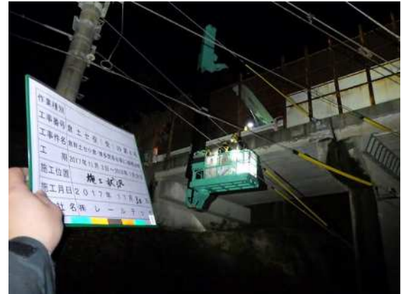
[ 橋梁点検車による定期点検状況 ]
