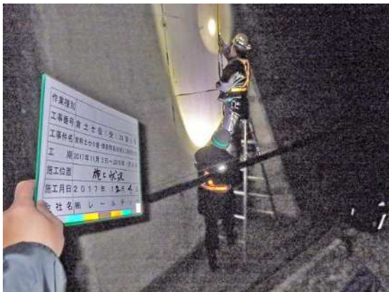
[ 脚立による定期点検状況 ]
