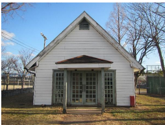
鞍手町立テニス場クラブハウス
