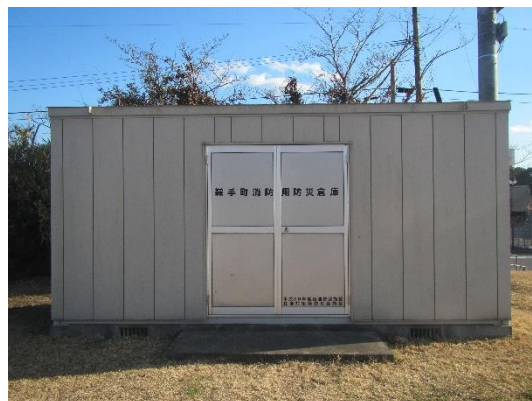
消防用防災倉庫
