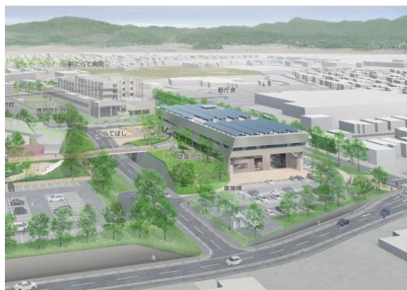
■ 新庁舎の建設
